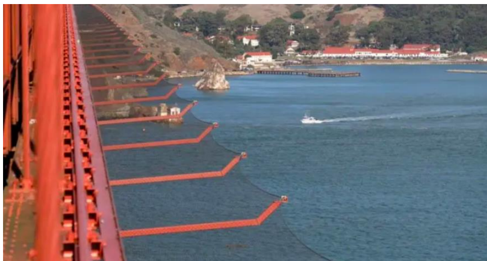
Malla instalada puente Golden Gate. Fuente: Getty Images en BBC 28
